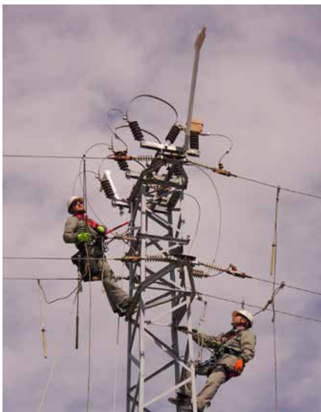
Снимки 19 и 20: Обезопасени с кацалки за птици стълбове от тип 6 (РОС) с изцяло изолирани токопроводими елементи по системата PAS
