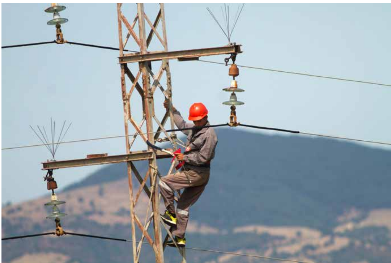
Снимка 24: Метални „щъркобрани“ за стоманорешетъчни стълбове за ВЕЛ 20kV, монтирани над висящи изолатори на стоманорешетъчен стълб от тип 10 и изолирани с шлаух проводници
