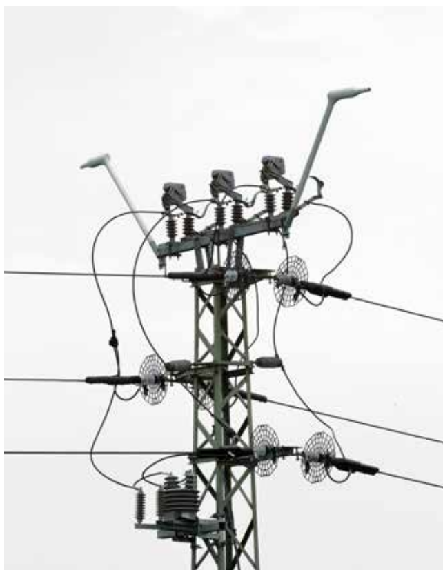
Снимки 19 и 20: Обезопасени с кацалки за птици стълбове от тип 6 (РОС) с изцяло изолирани токопроводими елементи по системата PAS
