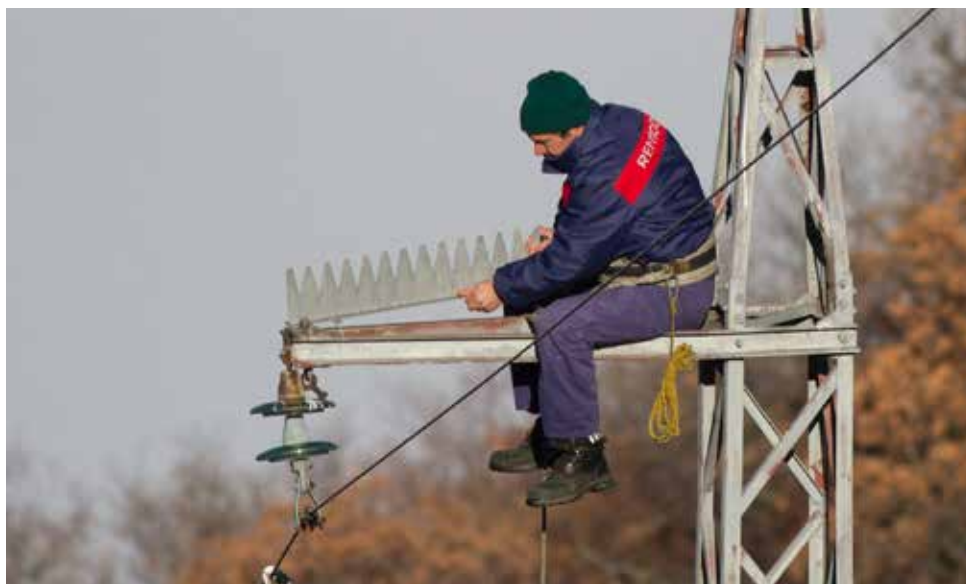
Снимка 35: Монтаж на гребени върху стоманорешетъчен стълб (тип, който стандартно се ползва за 110 kV) с висящи изолатори в Натура 2000 зона „Кресна“.
