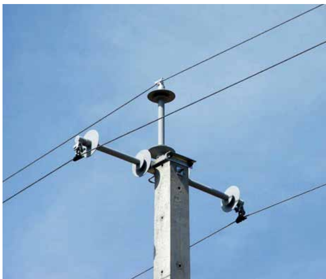
Снимка 11: Унгарска конзола с изцяло изолирани със силикон рамена тип Nyír-Mix SZKK25. Този тип е използван за пример при разработването на българската конзола за стоманобетонни стълбове.
