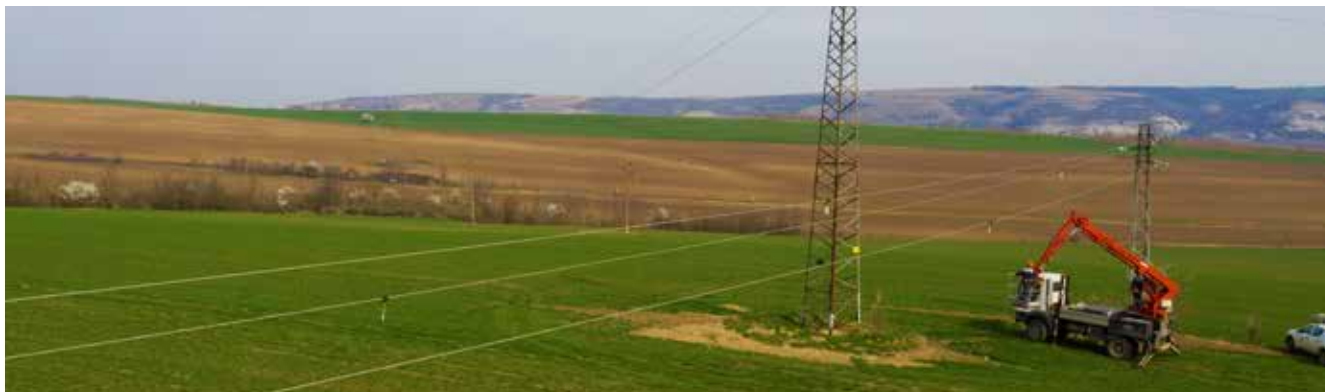
Снимка 45: Дейности по монтаж на дивертори от екип на ЕРМ Запад.
