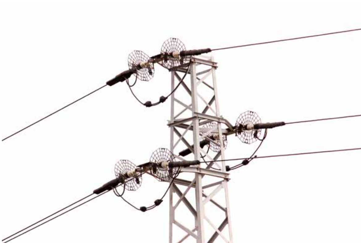
Снимка 22: Птицезащитни решетки, монтирани на опъвателен стоманорешетъчен стълб от тип 1 с изцяло изолирани токопроводими елементи по системата PAS
