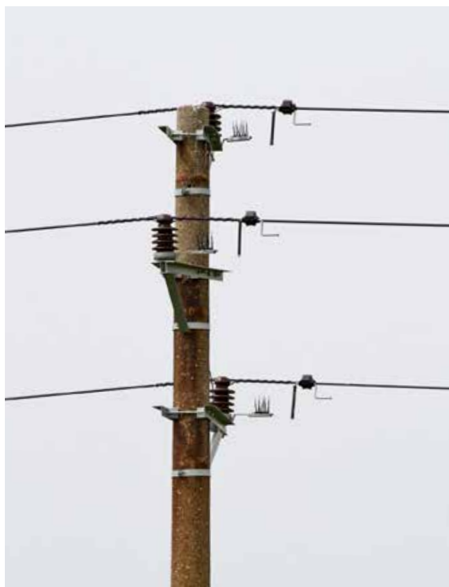
Снимки 16 и 17: Стоманобетонни стълбове от тип 2 с изцяло изолиран въздушен проводник и „искрища“ (PAS система) в Натура 2000 зона „Сакар“
