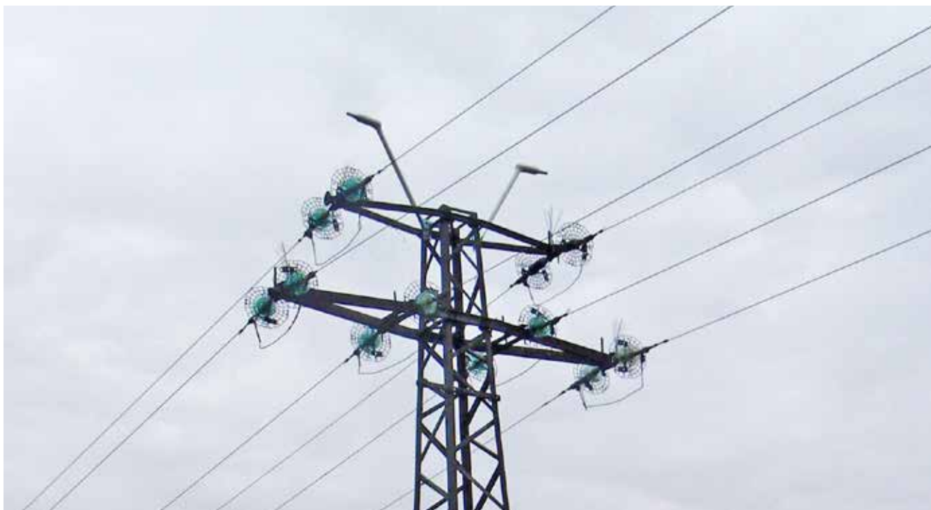
Снимка 21: Обезопасен стълб тип 9 с кацалки за птици, птицезащитни решетки за изолаторни вериги СрН и метални щъркобрани по проект „Живот за птиците“ LIFE16 NAT/BG/000612
