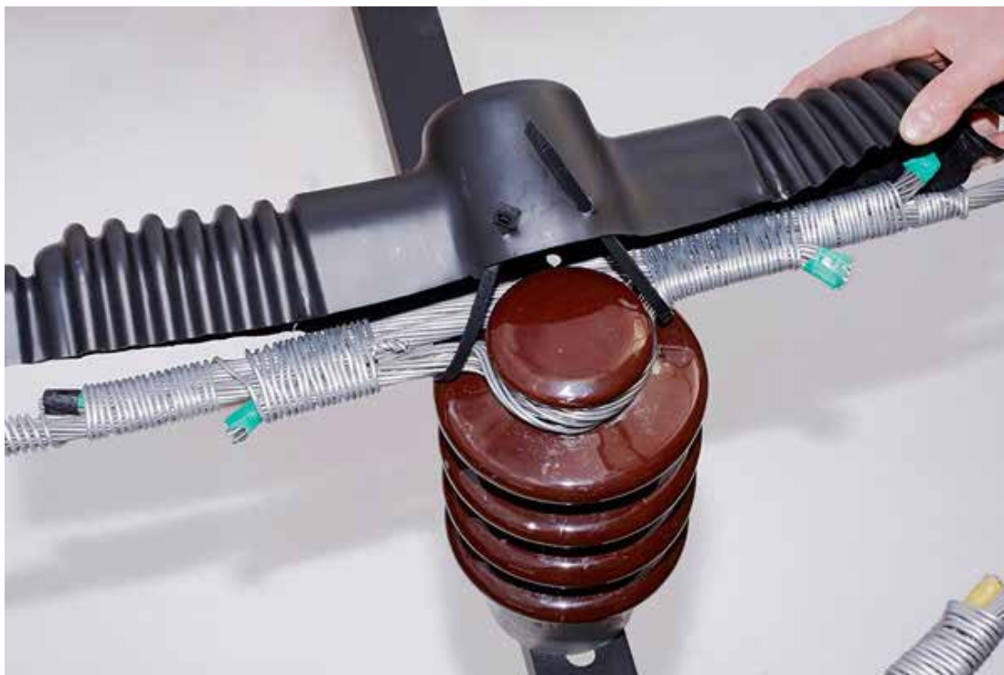
Снимка 25: Монтиране на изолационно покритие върху носещ изолатор с помощта на самозаклЮчващи се кабелни превръзки тип „свински опашки“
