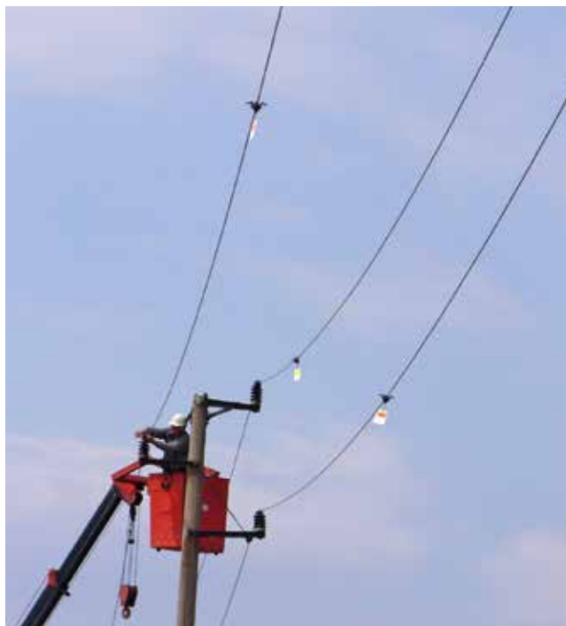
Снимки 38 и 39: Монтаж на дивертори в Натура 2000 зони „Комплекс Беленски острови“ и „Атанасовско езеро“ по проекти на БДЗП в партньорство с Електроразпределителни мрежи Запад и Електроразпределение Юг
