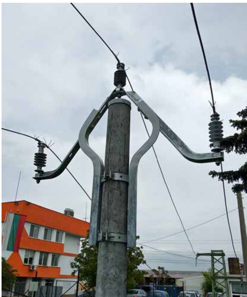
Снимка 15: Френска конзола за една тройка носещи изолатори и монтажни профили с нанесено изолационно покритие, тествана в учебния център на ЕРМ Запад в рамките на проект „Живот за птиците“ (LIFE16 NAT/BG/000612)
