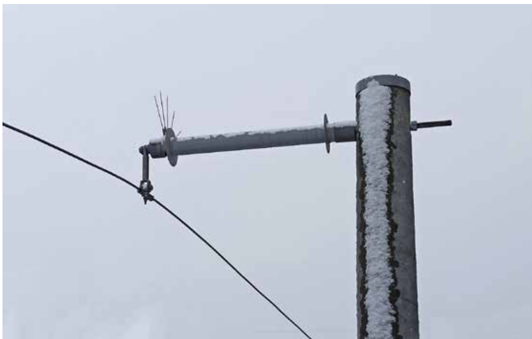
Снимка 10: Българска конзола за стоманобетонни стълбове, разработена по проекта „Живот за птиците“ (LIFE16 NAT/BG/000612), с изцяло изолирани със силикон рамена, разработена по подобие на унгарската Nyír-Mix SZKK25. Първи монтиран прототип в учебния център на „ЕРМ Запад“ АД в София
