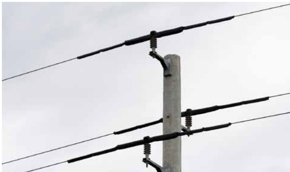
Снимка 28: Стоманобетонен стълб от тип 2 с монтирани изолационни покрития с удължители в Натура 2000 зона „Западна Странджа“
