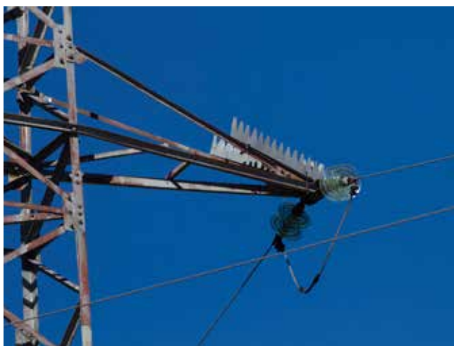
Снимка 36: Монтирани гребени върху стоманорешетъчен стълб (тип, който стандартно се ползва за 110 kV) с опъвателни изолатори.
