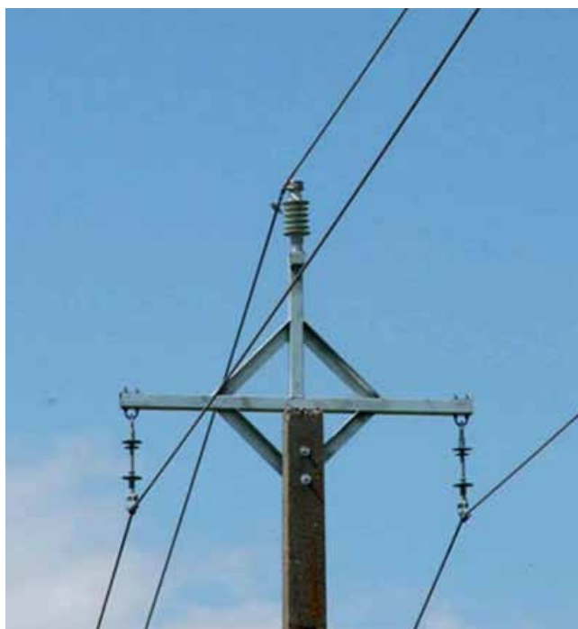
Снимка 13: Унгарска конзола с един стоящ и два висящи изолатора тип PÖYRY Erőterv Zrt. TvBH2
