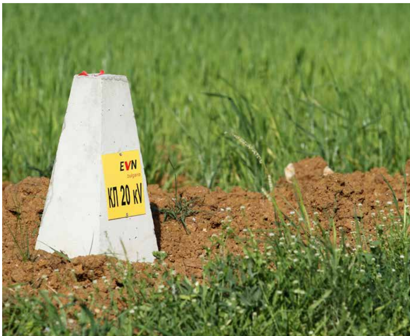
Снимка 9: Маркировъчна пирамида на подземна кабелна линия от 43 км, заменила 70 км опасен за птиците въздушен електропровод в Натура 2000 зона „Сакар“ (проект „Живот за царския орел“ LIFE12NAT/BG/000572 на Електроразпределение Юг и БДЗП)
