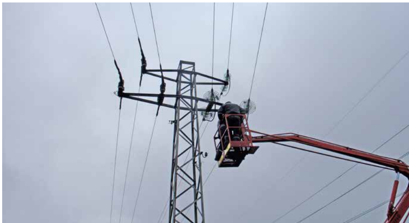
Снимка 23: Птицезащитни решетки за изолаторни вериги СрН и изолационни покрития за носещи изолатори 20 kV, поставени по проект LIFE16 NAT/BG/000612, СЗЗ Врачански Балкан
